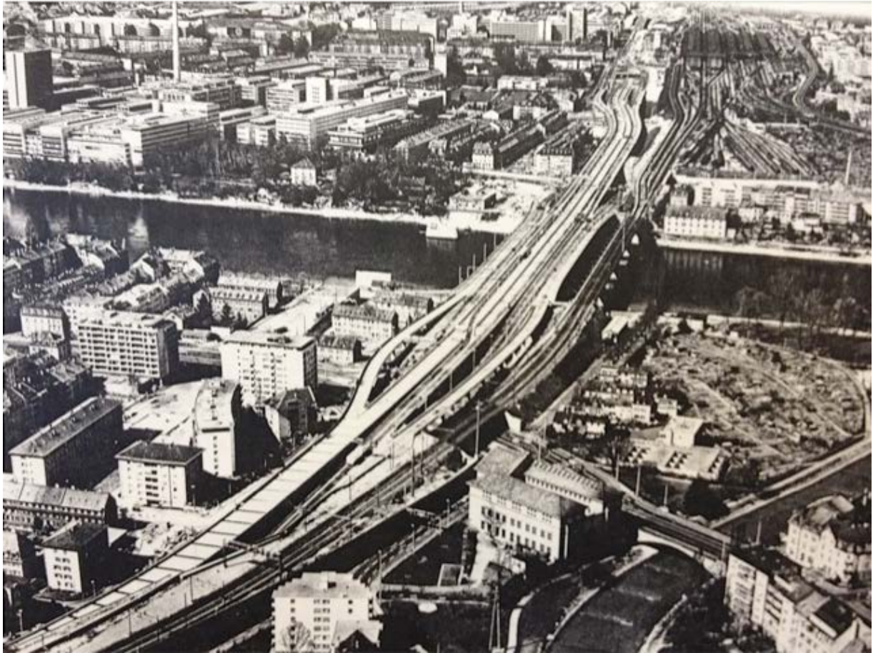
Etwa 1975 Die Autobahnbrücke kurz nach der Fertigstellung.
