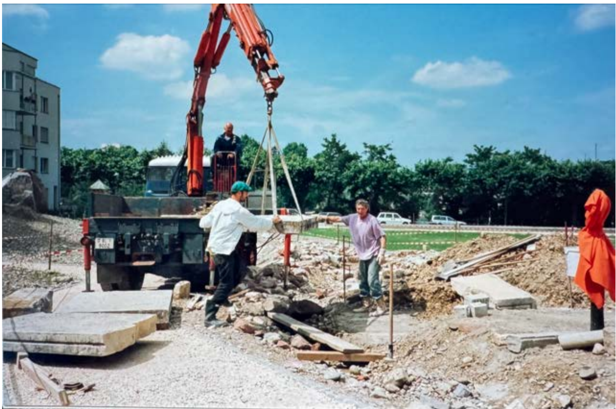
1993 Spontanbau der Brunnenanlage auf der Cécile Ines Loos-Anlage.
